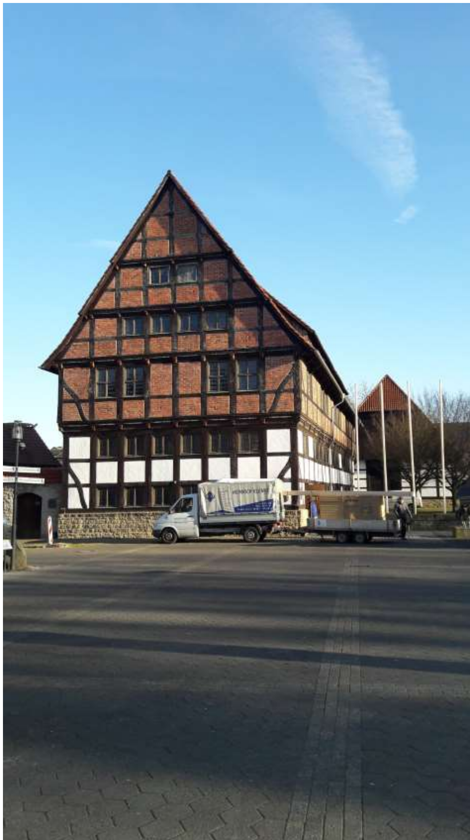
Die markante Stirnseite des Kornhauses wird denkmalpflegerisch instandgesetzt / Foto: Lippisches Landesmuseum Detmold
